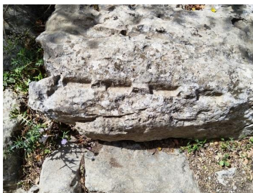
Εικόνα 11. Ορθογώνιες εγκοπές στο «χείλος» του αγωγού.
