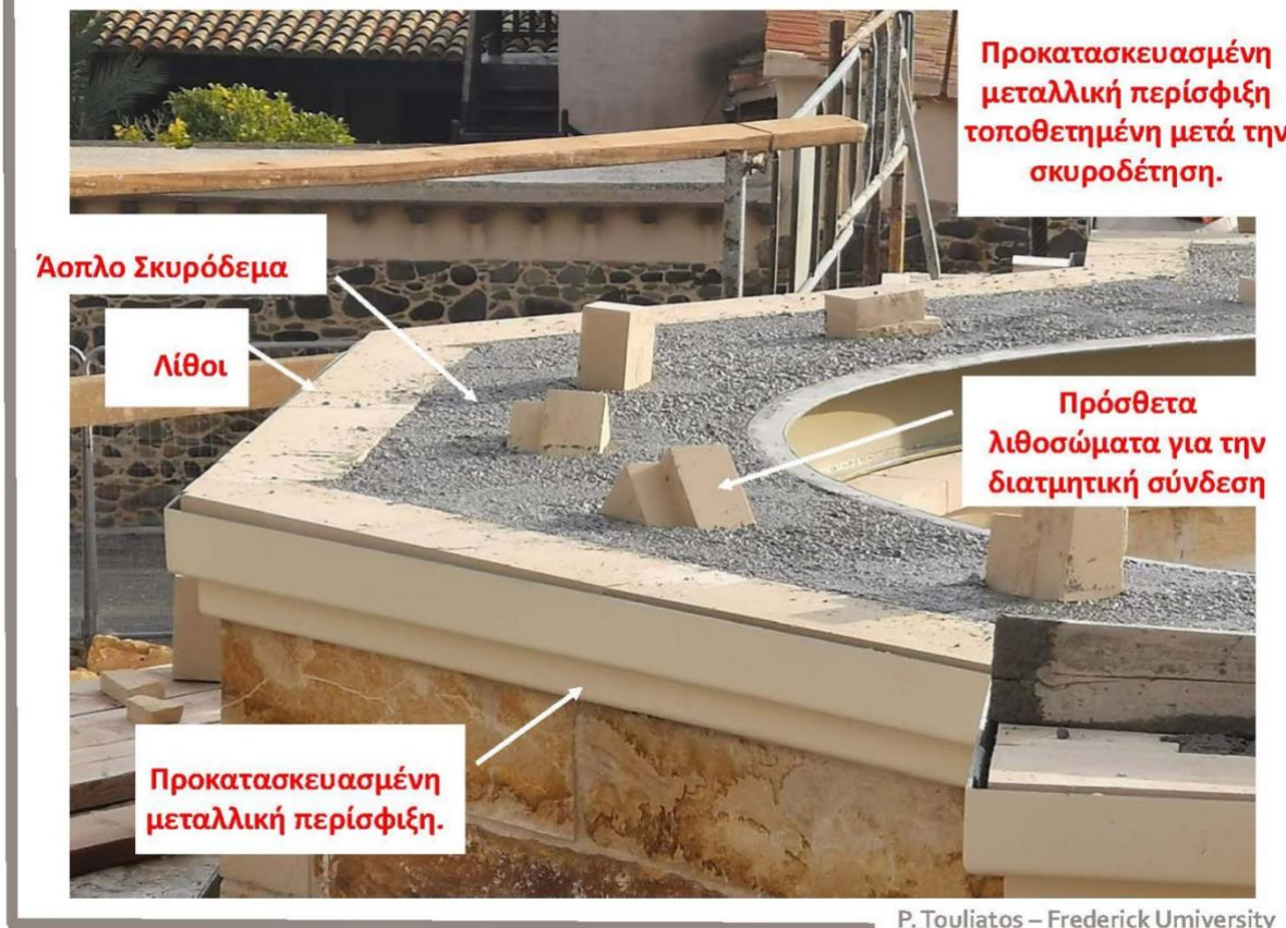
Εικ. 30. Ιμάντωση, η οποία χρησιμοποιήθηκε και ως καλούπι για την ζώνη διάστρωσης του σκυροδέματος, με ενσωματωμένα λιθωσώματα για την διατημητική σύνδεση με την, καθ' ύψος προστιθέμενη λιθοδομή.
