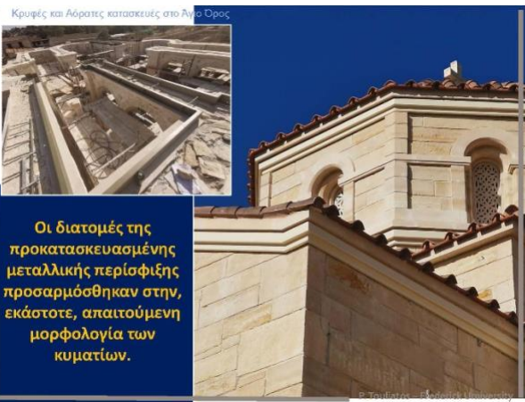
Εικ. 29. Αριστερά, η τοποθέτηση του προκατασκευαζόμενου τμήματος Ιμάντωσης, που θα χρησιμοποιηθεί και ως καλούπι για την ζώνη διάστρωσης του σκυροδέματος. Δεξιά, οι ζώνες περισφίξεων και ιμαντώσεων κατάλληλα εντεταγμένες μορφολογικά στις γλυφές των κυματίων.
