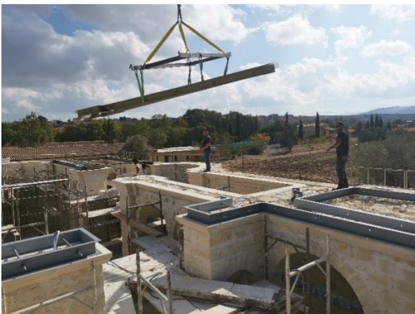
Εικ. 29. Αριστερά, η τοποθέτηση του προκατασκευαζόμενου τμήματος Ιμάντωσης, που θα χρησιμοποιηθεί και ως καλούπι για την ζώνη διάστρωσης του σκυροδέματος. Δεξιά, οι ζώνες περισφίξεων και ιμαντώσεων κατάλληλα εντεταγμένες μορφολογικά στις γλυφές των κυματίων.
