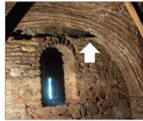
Εικ. 12. Η ύπαρξη Κρυφών Ξύλινων Ιμαντώσεων εντός των φερουσών λιθοδομών.
