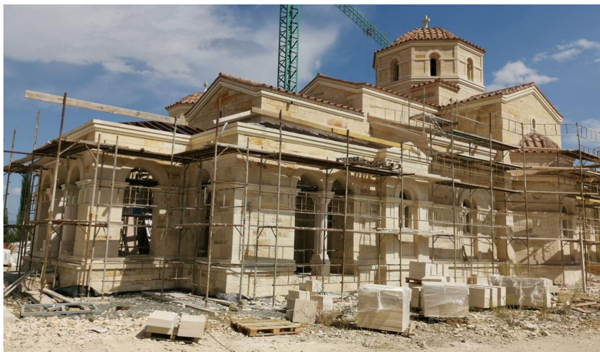
Εικ. 24. Ο λιθόκτιστος Ιερός Ναός του Αγίου Φιλουμένου, στην Ορούντα της Κύπρου, υπό κατασκευή (2023).
