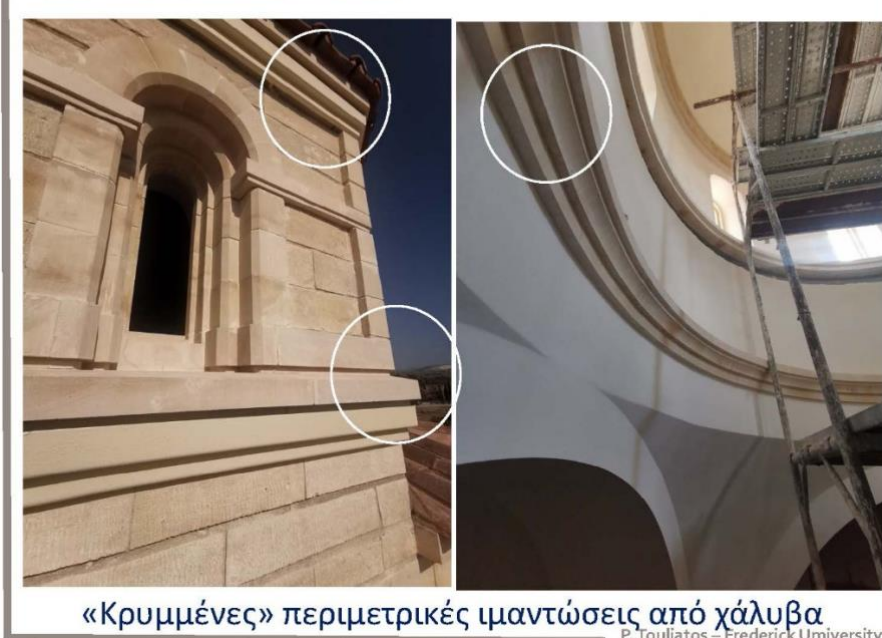
Εικ. 31. Το τελικό μορφολογικό αποτέλεσμα της ζώνης Ιμάντωσης, μέσα και έξω από τον Ναό.
