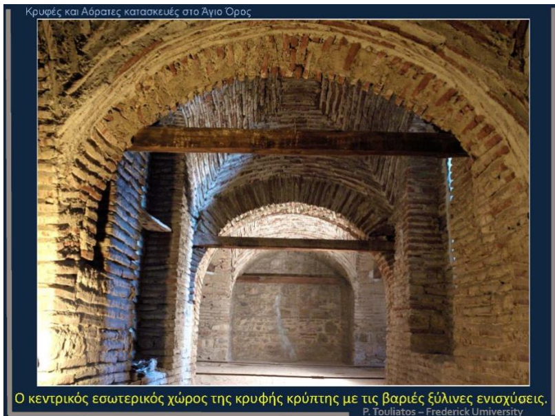
Εικ. 8. Οι εντός της Κρύπτης διακρινόμενες Ξύλινες Ιμαντώσεις, εντός και εκτός των λιθοδομών.
