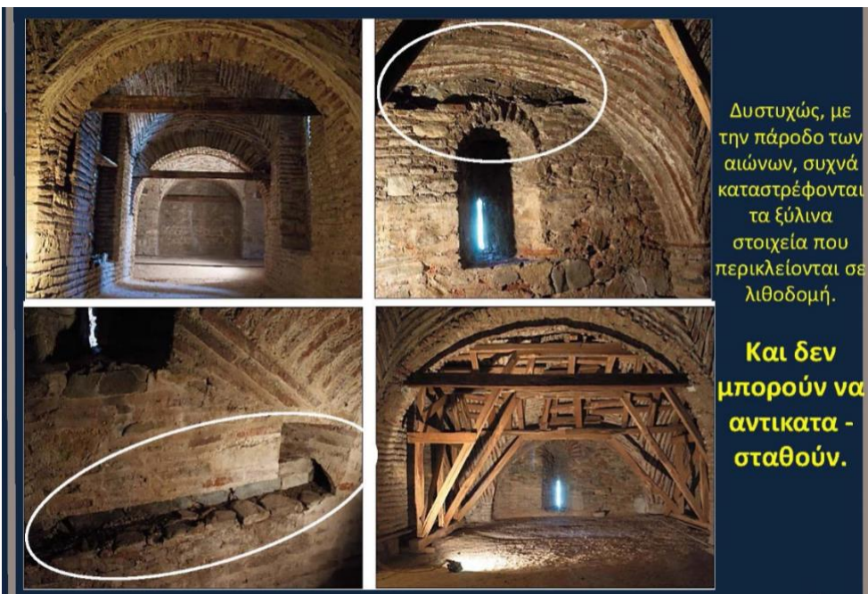
Εικ. 23. Η φθορά των ξύλινων ιμαντώσεων, των ξυλοδεσιών, εντός διαβρεχόμενης λιθοδομής.
