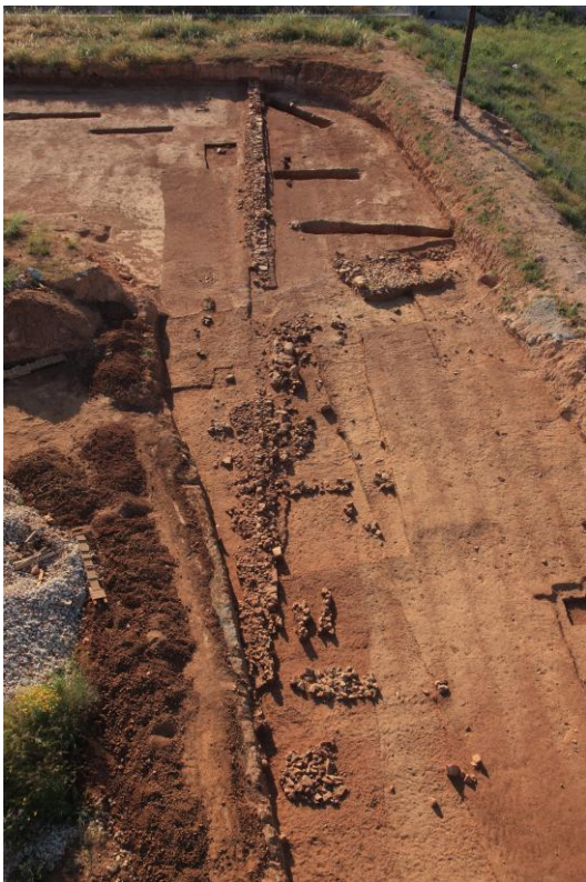
Εικόνα 24 Τοίχος ανάσχεσης των επιφανειακών υδάτων στο Δ άκρο του οικοπέδου Λιντλ.
