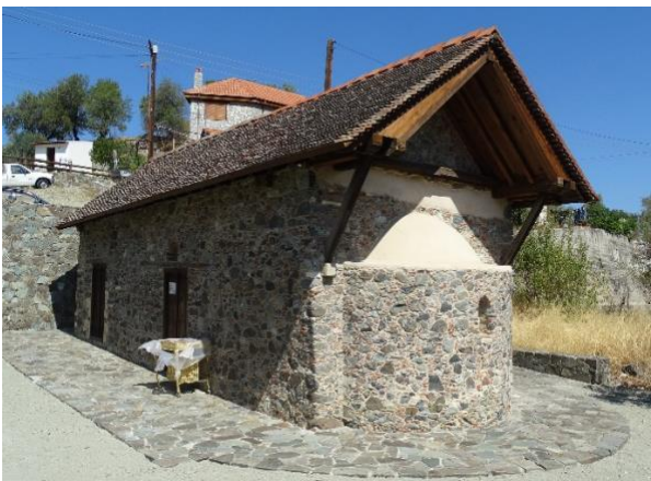
Εικ. 13. Νοτιο-ανατολική άποψη του Ναού του Αγίου Μάμα στο χωριό Λουβαράς. (Φωτ. Μ.Πελεκάνος)
