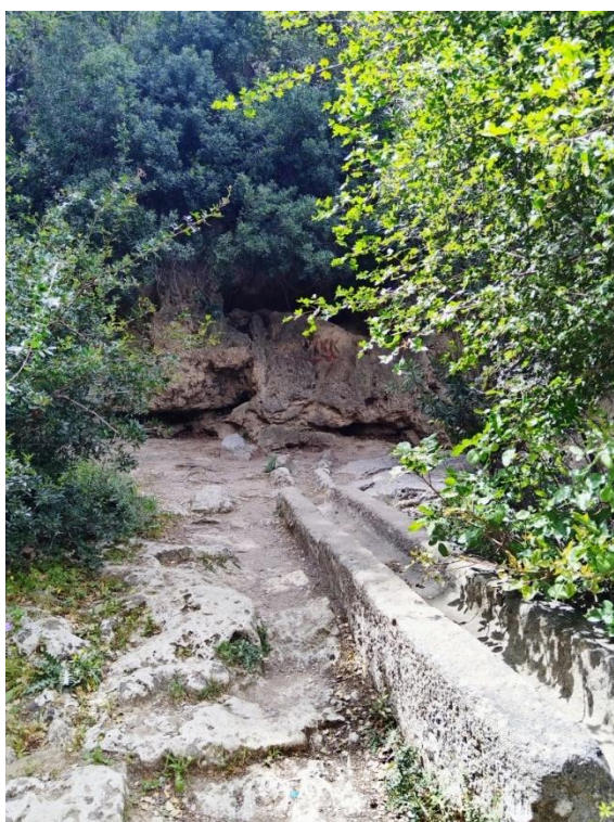
Εικόνα 9. Μονολιθικός αγωγός λαξευμένος σε επιμήκη πλίνθο από τραχείτη στο τμήμα που περνά από το «Γεφύρι του Διαβόλου».
