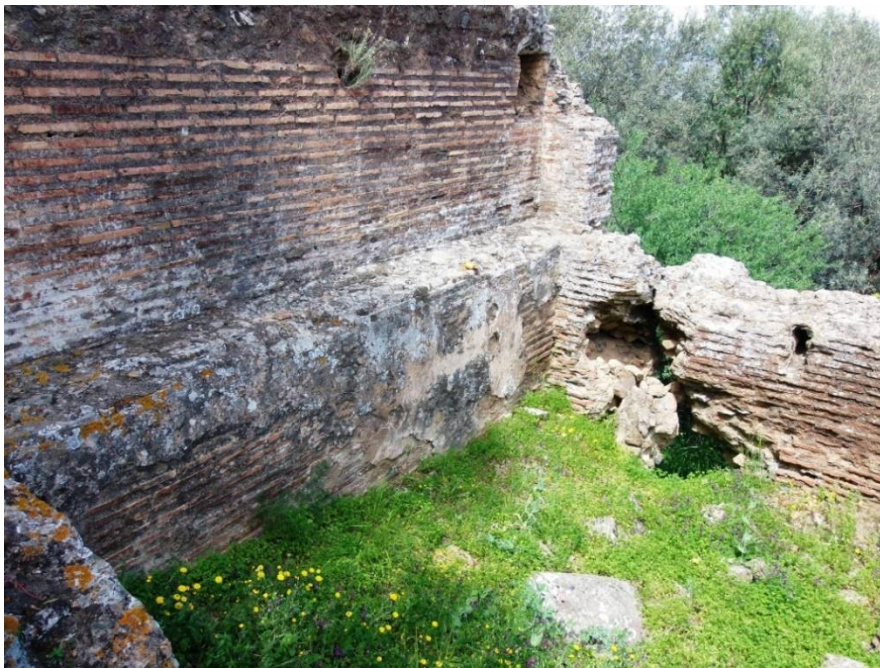
Εικόνα 15. Το εσωτερικό της δεξαμενής, από ΝΑ. Στον βόρειο τοίχο διακρίνεται μικρή διαμπερής οπή για την εκροή του νερού.
