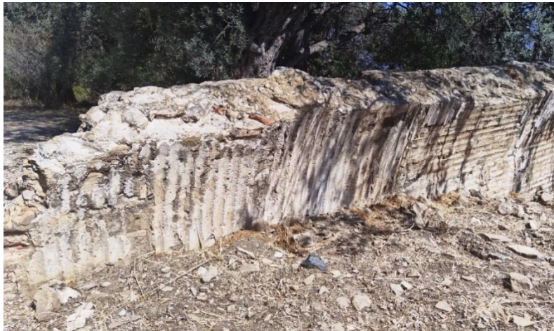
Εικόνα 17. Πυκνές κάθετες αυλακώσεις στο επίχρισμα από ασβεστοκονίαμα σε καμάρα της στέγης του βαλανείου.
