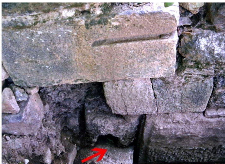
Εικόνα 12. Λίθινη πλίνθος αγωγού σε σχήμα U, ενσωματωμένη ως οικοδομικό υλικό στην τοιχοδομή μεσαιωνικού κτηρίου ΝΔ του Αγίου Ιωάννη.
