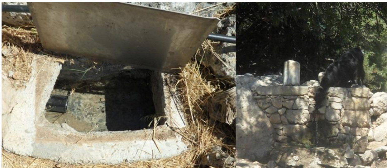
Εικόνα 14. Εντοιχισμένη ή μια από τις υδατοπαροχές του πρώτου υδροσημείου (Lissos 1) της πηγής, που τροφοδοτεί την επίκαιρη κρήνη (δεξιά) του Ασκληπιείου και χρησιμοποιείται από τους χιλιάδες επισκέπτες του χώρου.
