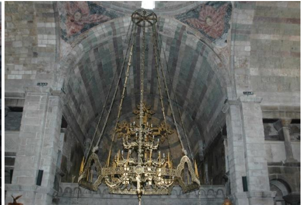
Εικόνα 5. Άποψη της ανατολικής καμάρας και των πεσσών.
