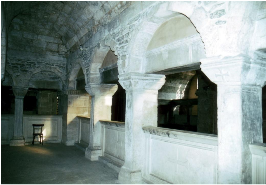
Εικόνα 8. Σύστημα στήριξης θόλων του ορόφου των υπερώων.
