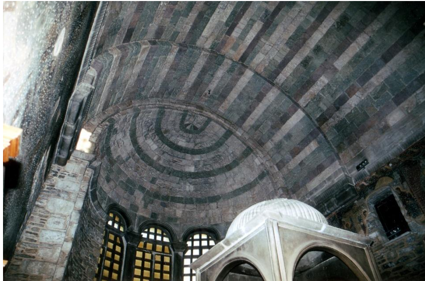
Εικόνα 10. Άποψη της ανατολικής κεραίας
