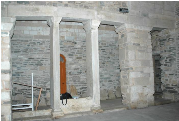
Εικόνες 21-22. Οι φορείς της θολοδομίας του Βαπτιστηρίου εσωτερικά και εξωτερικά.
