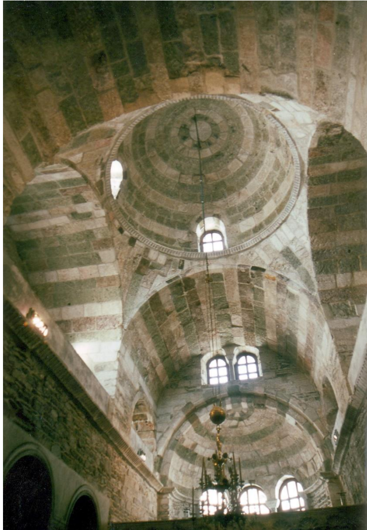
Εικόνα 14. Άποψη της Θολοδομίας του Αγίου Νικολάου.
