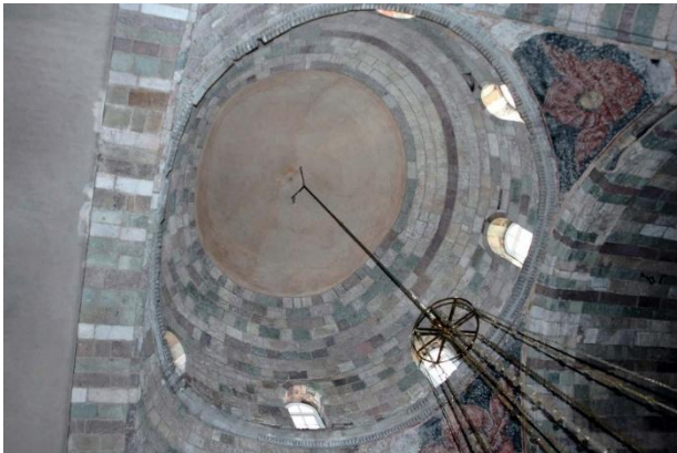
Εικόνα 4. Άνοψη στην περιοχή του τρούλλου
