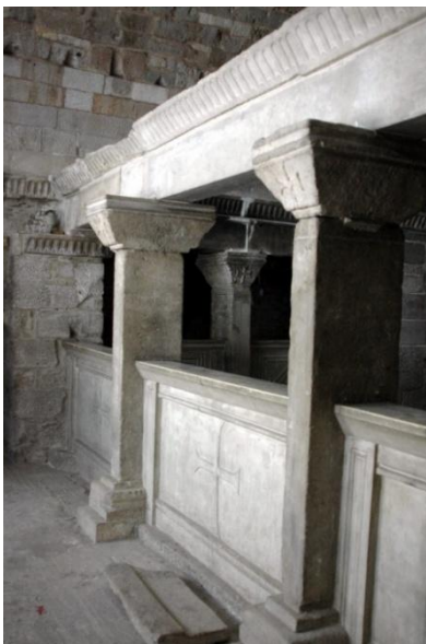
Εικόνα 9. Επιστύλια χωρίς στατική λειτουργία.
