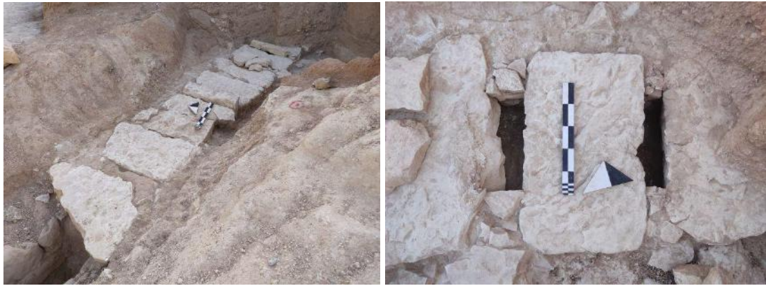
Εικόνες 22, 23. Οι καλυπτήριες πλάκες του κτιστού τμήματος της Αύλακας 2 (αριστερά) και τα ανοίγματα μεταξύ των πλακών (δεξιά).
