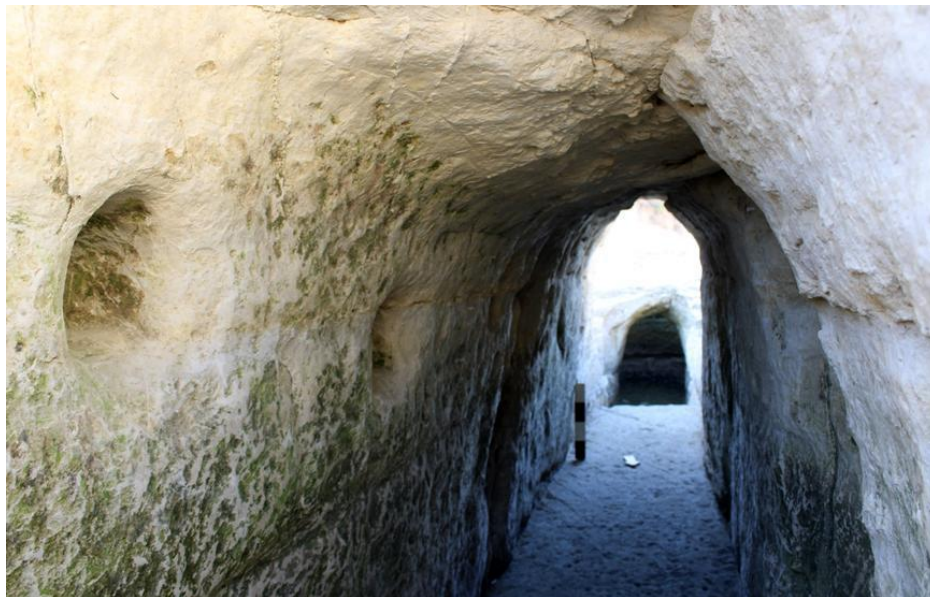
Εικόνα 8. Άποψη του εσωτερικού της Σήραγγας Α από τα βόρεια, όπου φαίνονται οι κοιλότητες στο ανατολικό τοίχωμα.
