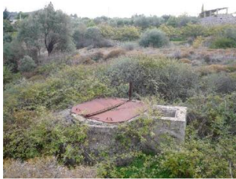
Εικόνα 17. Φρεατοειδής δεξαμενή στο σημείο υπ' αριθμόν 11 της Εικόνας 16 , πλησίον της κάμψης του υδραγωγείου προς τα δυτικά.
