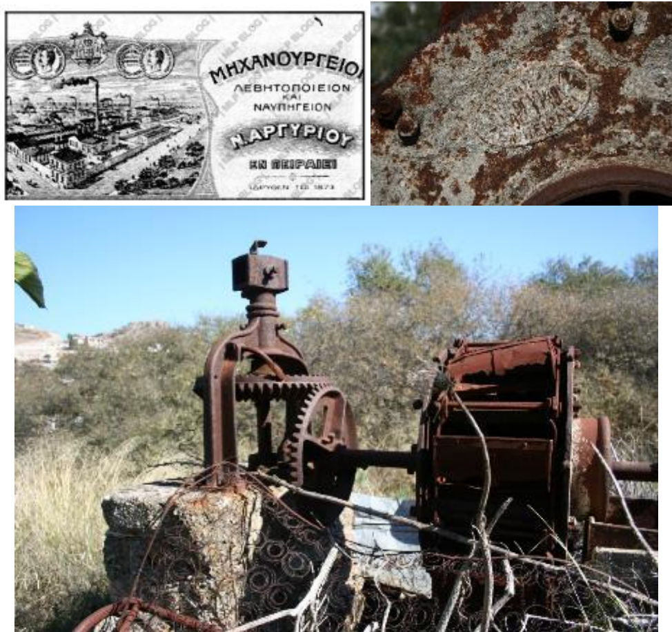
Εικόνα 6. Μάγγανο του 19 ου αιώνα κατασκευής «Αργυρίου» στου Κοντού
