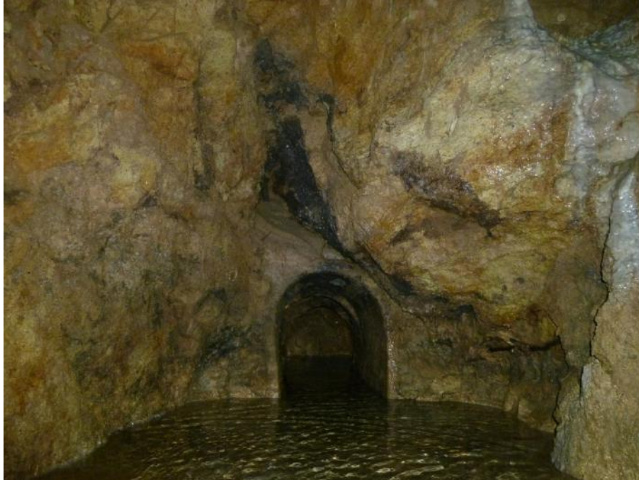
Εικόνα 14. Ο πεταλόσχημος κεραμικός αγωγός στο θάλαμο, πλησίον του φανού A9.
