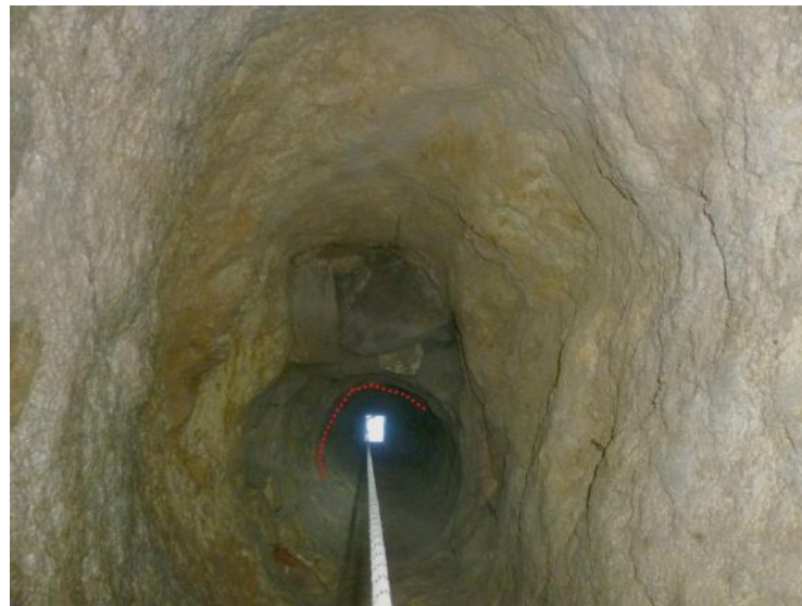
Εικόνα 13. (α): Κεραμική επένδυση, κατά μήκος της σπικτικής γραμμής, σε φανό που δεν αποκαλύπτεται στην επιφάνεια μεταξύ Α3 και Α4. (β): Κεραμική επένδυση στο φανό Α9, κατά μήκος της σπικτικής γραμμής σε μικρό βάθος.
