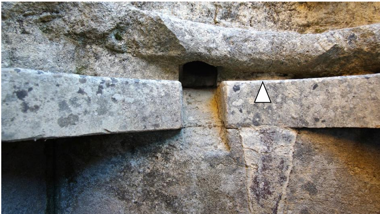
Εικ. 6. Η έξοδος του καναλιού επικοινωνίας στο ανώτερο σημείο του δυτικού τοιχώματος του θαλάμου. Με βέλος σημειώνεται το μολύβδινο παρέμβλημα μεταξύ πλάκας και περικοχλίου.
