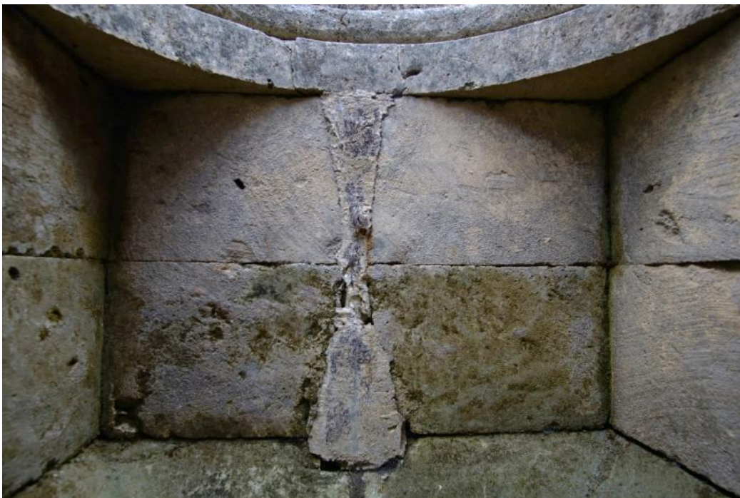
Εικ. 4. Το ανατολικό τοίχωμα του θαλάμου με τη μολυβδοχορημένη εντορμία. Διακρίνεται και η κατακόρυφη μεταλλική ράβδος.
