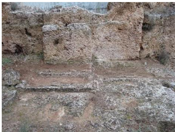
Εικόνα 12 (αριστερά). Λατομείο 2. Σειρά ιχνών από την ένθεση σφηνών σε συνεχή αύλακα, μπροστά από την αύλακα λιθοτομίας για την απόσπαση της λιθοπλίνθου.
