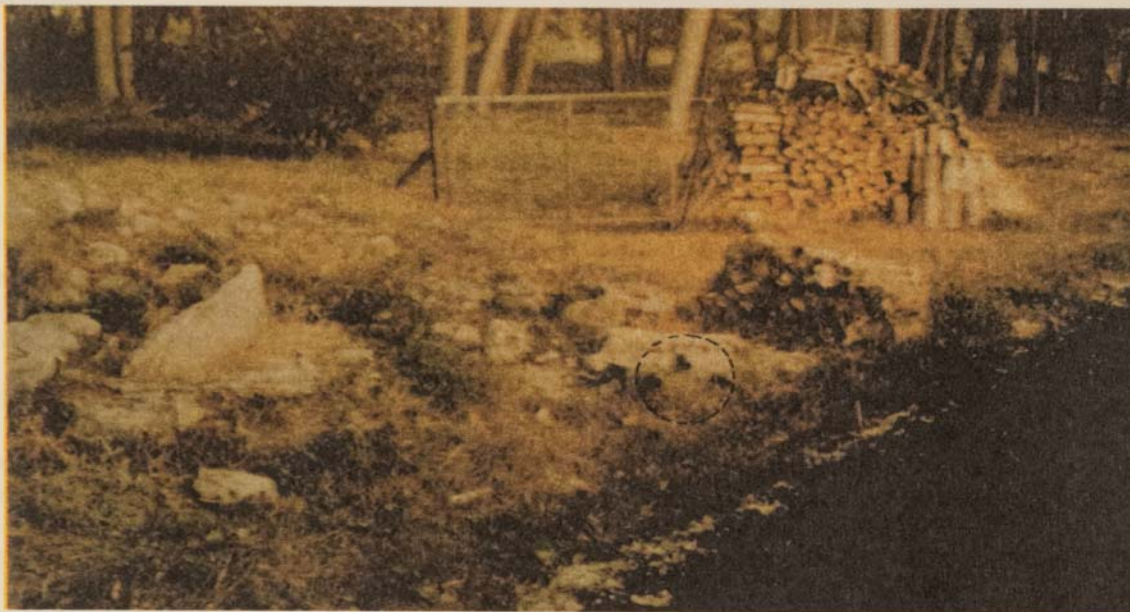
ΕΙΚ.4 Βρύση χωρίς νερό του Σ.Σ. Αγγίστας Σερρών. Η αδρανοποίησή της οφείλεται στην πρόσχωση από τις πλημμύρες του 1957 του συστήματος υδρομάστευσης/ υδραγωγής που την τροφοδοτούσε με νερό. Τρεις από τους εννέα κρουνοί της βρύσης διακρίνονται στην φωτογραφία. Pipeline network without water of Rail Station of Agista Serres. The inactivation of the pipeline network caused by deposition of mud into the Qanat after 1957 floods. Three out of nine pipelines are shown in the foto.
