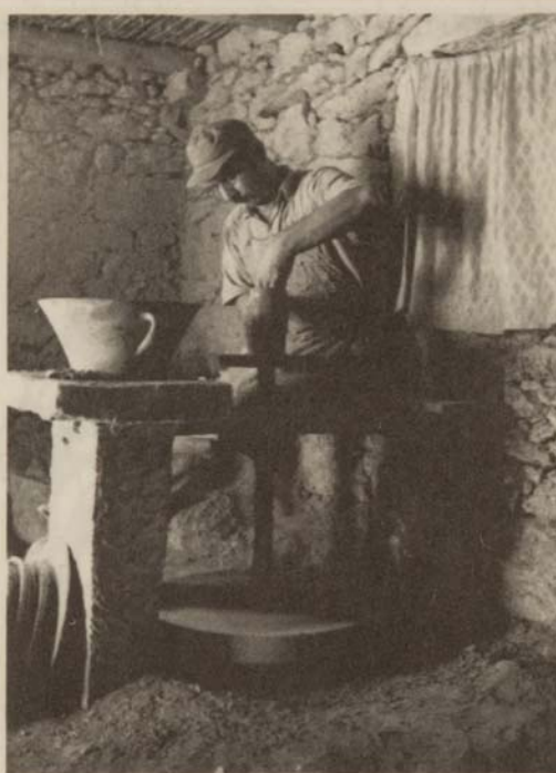
ΕΙΚ.3 Ο υψηλός ποδοκίνητος τροχός σε λειτουργία (Μαργαρίτες 1983 Φωτ ΜΚΕ) The high, foot rotated wheel in operation (Margarites 1983 Photo MCE)
