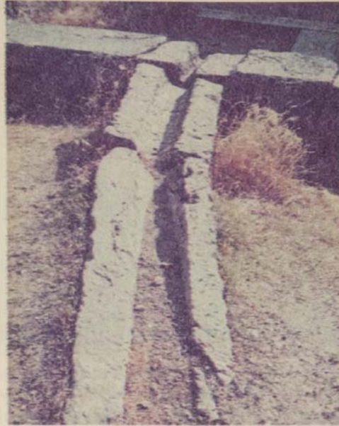
ΕΙΚ. 2 Μαρμάρινη υδαιούλαξ στην Κόρινθο Curved marble culvert in Corinth
