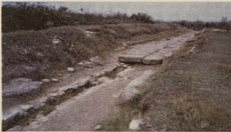
ΕΙΚ. 3 Κεντρική οδός με υπόγειο αποχετευτικό αγωγό στο Δίον Main street and underground sewer in Dion
