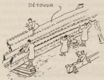
ΕΙΚ. 3 Εφαρμογή της μεθόδου shell-first. Σχέδιο J.-M. Gassend.
