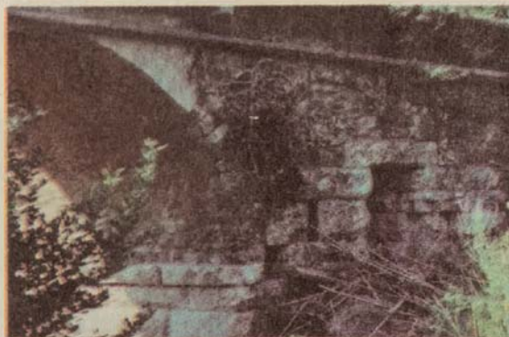
ΕΙΚ. 4 Γέφυρα Μαυροζούμαινας
