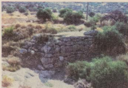
ΕΙΚ. 1 Γέφυρα Χαβόν
