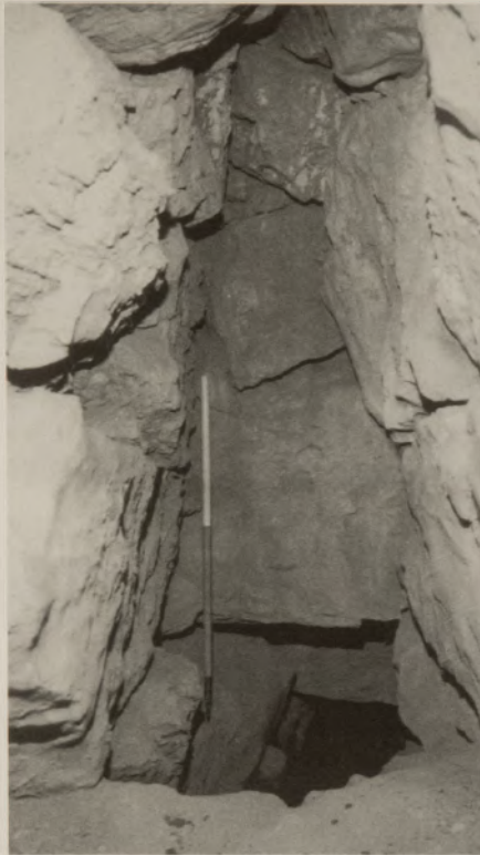
Abb. 6. Tiryns. Detailaufnahme der Abdeckung des Nordganges am Übergang des Kragsteingewölbes zu den Sturzblöcken. Photo: P. Marzoff
