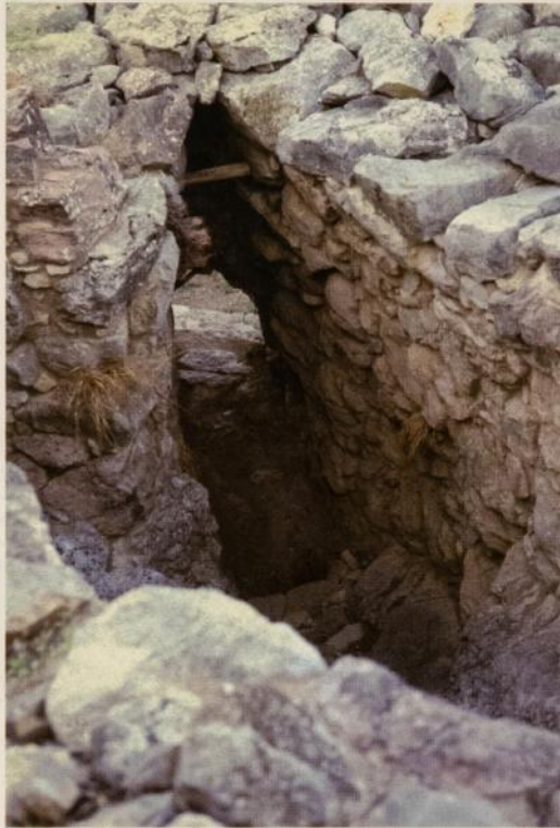
Abb. 9. Tiryns. Blick auf den unteren Abschnitt der Westtreppe. Photo: J. Maran
