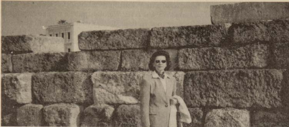
ΕΙΚ.4 Τείχος πλησίον του Ιερού της Αφροδίτης, όπου οι ογκόλιθοι ηφαιστειτή εδράζονται σε σπρώμα από λατόμες του ίδιου πετρώματος. Wall near the Temple of Venus, where the volcanic blocks rest on fragments of the same rock.
