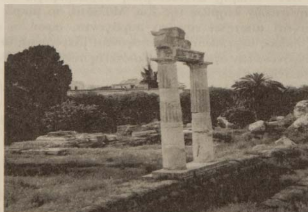
ΕΙΚ.6 Αναστηλωμένοι κίονες στην αρχαία Αγορά επάνω σε θεμελίωση από ογκόλιθους ηφαιστειτή. Restoration of columns in the ancient Agora founded on volcanic blocks. The quarries of volcanic rock at Kefalos Bay, Kos Island, and their contribution to the foundation of the Hellenistic city of Ko.
