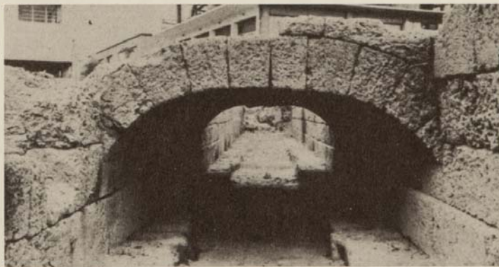
ΕΙΚ. 7 Η θολωτή κάλυψη του αγωγού στη Ρόδο (από ΑΔ:Χρον. 23 [1968] νίν. 414). The vaulted cover of the drain at Rhodes.
