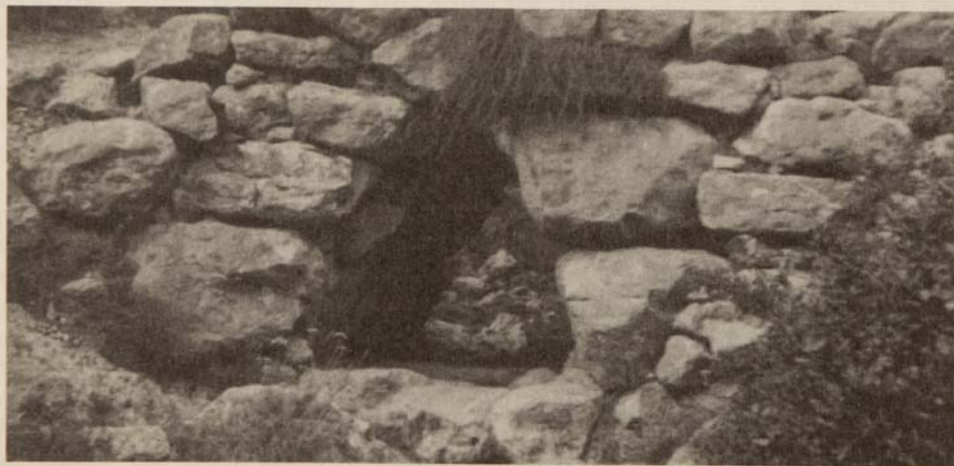
ΕΙΚ. 5 Η νότια όψη της γέφυρας Γαλούση στο Αρκαδικό. The south face of the bridge Galousi at Arkadiko.
