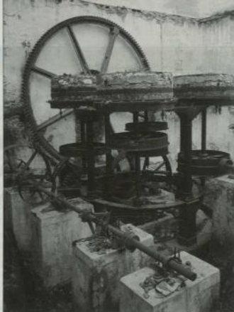
2. Το εσωτερικό του στήθους Εμπορίου στην Άνδρα (φωτ. Α. Σπυρογιάννη). Τεχνολογία 3 (1989), εξώφυλλο.
