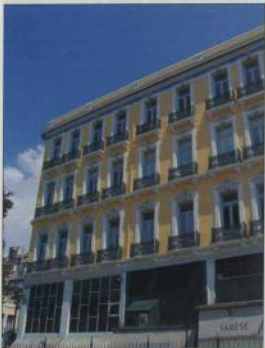
6. Το Μέγαρο Σπυράκης, στον Πειραιά είναι ένα από τα πρώτα αστικά κτίρια από μπετόν-αρμέ. Κατασκευάστηκε από την εταιρεία «Τέκτουρα» κατά τη δεκαετία του 1910. Παρά τη χρήση του νέου υλικού δεν παρατηρείται καμία ουσιαστική αλλαγή ως προς την αρχιτεκτονική από τα σύγχρονα του ύστερου νεοκλασικά, τα οποία κτιζόνταν με τις παλιές τεχνικές της πέτρας και του ξύλου.
