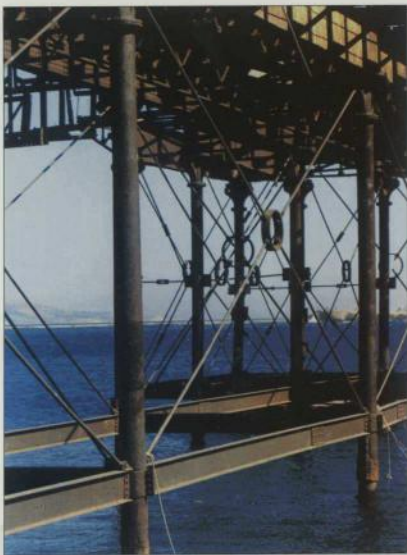
2. Αετιοφόρος της κατασκευής της σκάλας φέρουσας μεταλλωμάτων της Γαλλικής Εταιρείας Μεταλλικών Λαμαρίνας. Η μεταλλική σκάλα κατασκευάστηκε το 1888. Διακρίνεται η δομή του δεκτιμοστού με κυλινδρικούς στύλους, δοκούς διατομής διπλού T και διαγώνια αντιστήρια από ραβδούς που συνδέονται με δοκουλούς (φωτ.: Σ. Παπαδόπουλος, Β. Smith, 1998).
