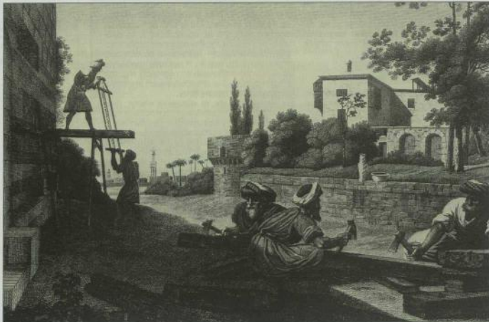
5. Σχίσμο ξυλοδοκών με «κατορόχνη», τελέκλιο με ακροπόδια [Πηγή: E.F. Jomard, Description de l'Égypte, Paris 1822, pl. II. Maury - A. Raymond - J. Revault - M. Zakariya, Palais et Maisons du Caire, v. II, CNRS, Paris 1983, c. 347].
