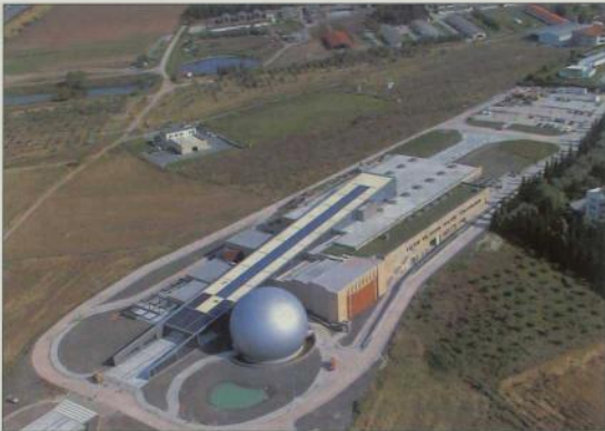
2. Οι νέες εγκαταστάσεις στην περιοχή Θέρμης Θεσσαλονίκης.
