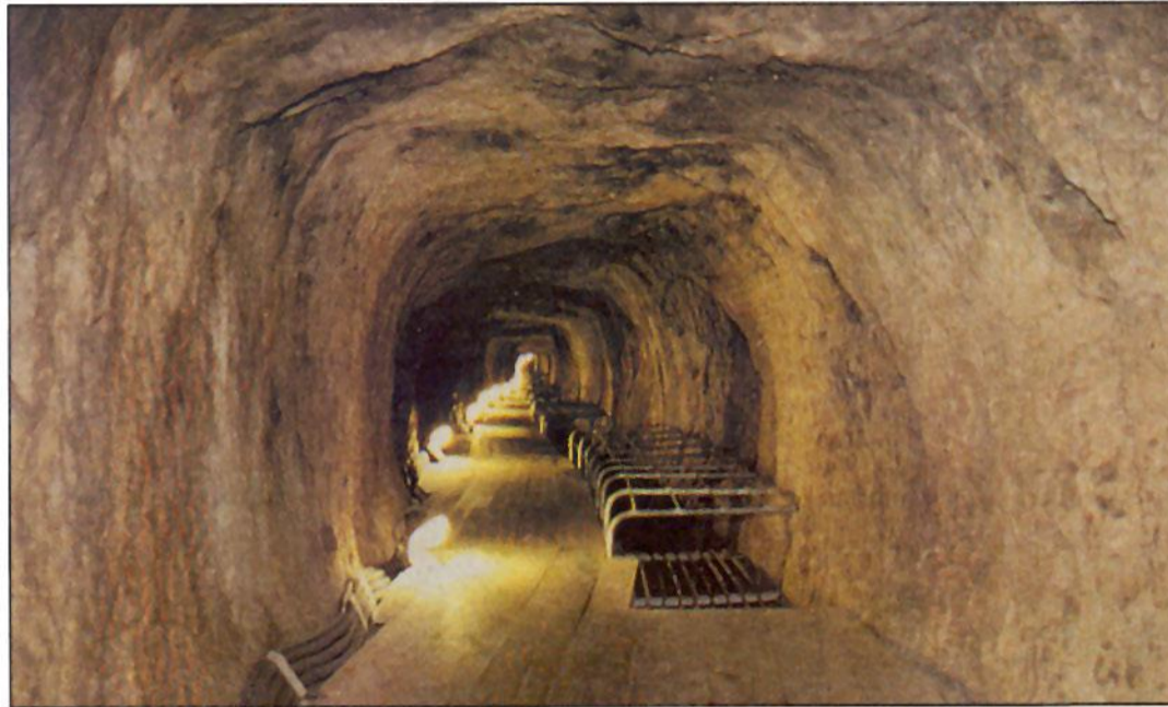
Εσωτερικό τμήμα του Ευπαλινείου ορύγματος (τούνελ). Αριστερά (το φωτιζόμενο) διακρίνεται ο διάδρομος διέλευσης επισκεπτών και δεξιά (το προστατευόμενο με μεταλλικό πλέγμα) το κανάλι μεταφοράς νερού (φωτ.: Βασ. Βαλής).
