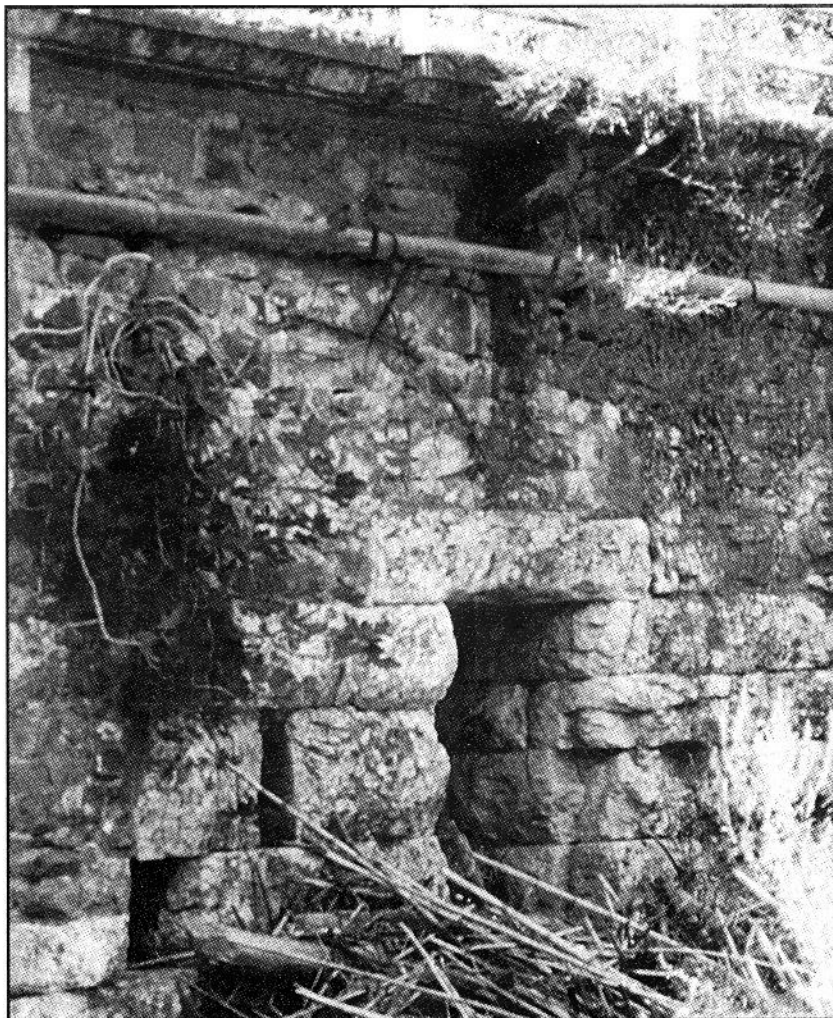
Ένα από τα πολλά ανοίγματα της αρχαίας (3ου π.χ. αι.) γέφυρας της Βαλύρας (άνω Πάμισος) όπως υπερυψώθηκε και χρησιμοποιείται μέχρι σήμερα (φωτ.: Γ. Γ. Μακρή).
