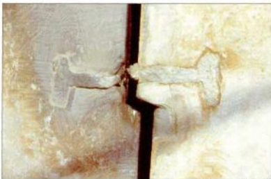
4. Σύνδεσμος από τον ναό του Παρθενώνα της ανατολικής σόδας των Προπυλαίων. Κατά την παραμόρφωση του τούλου ο σιδερένιος σύνδεσμος έλασσε με αποτέλεσμα το μάρμαρο να διατηρήσει την ακεραιότητά του.
